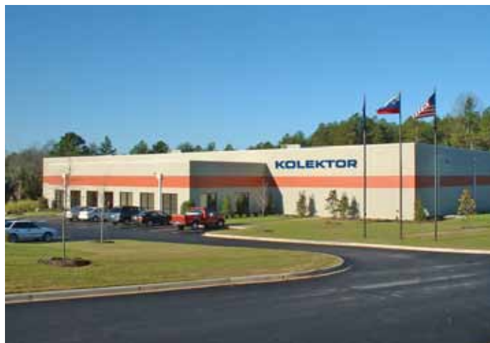
Pogled na Kolektor TKI
