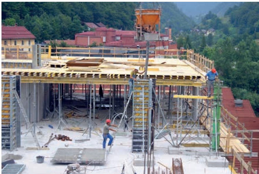
Gradnja RTC-ja je potekala v skladu s planom tudi po zaslugi finančne injekcije Kolektor Groupa
