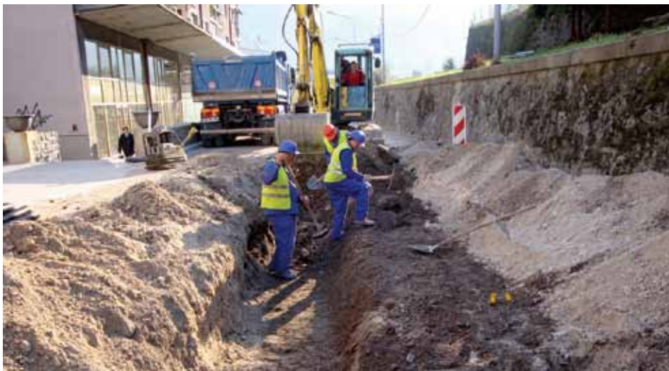
▲ Lapajnetova ulica v Idriji je dočakala celovito sanacijo
