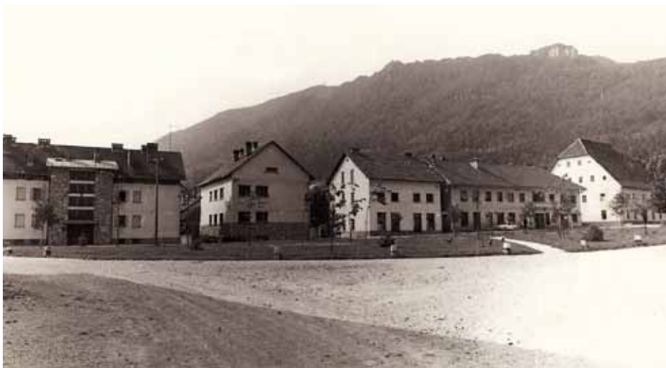
Črni Vrh nad Idrijo po obnovi
